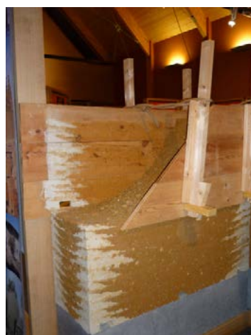
Détail d'une mise en œuvre traditionnelle d'un mur en pisé © photo CAUE62
