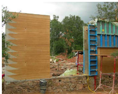
Mise en œuvre contemporaine d'un mur en pisé © photo Frédéric Evard
