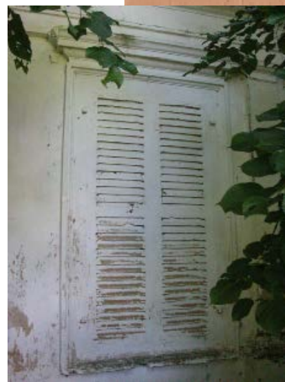
Détail persienne en stuc de terre et chaux de Samer © photo Frédéric Evard
