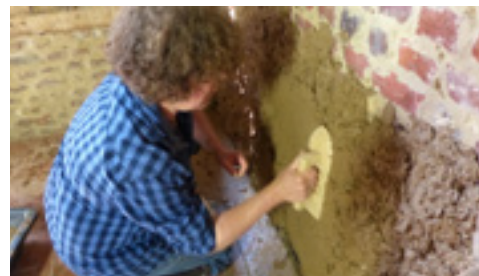
Pose de l'enduit intérieur
